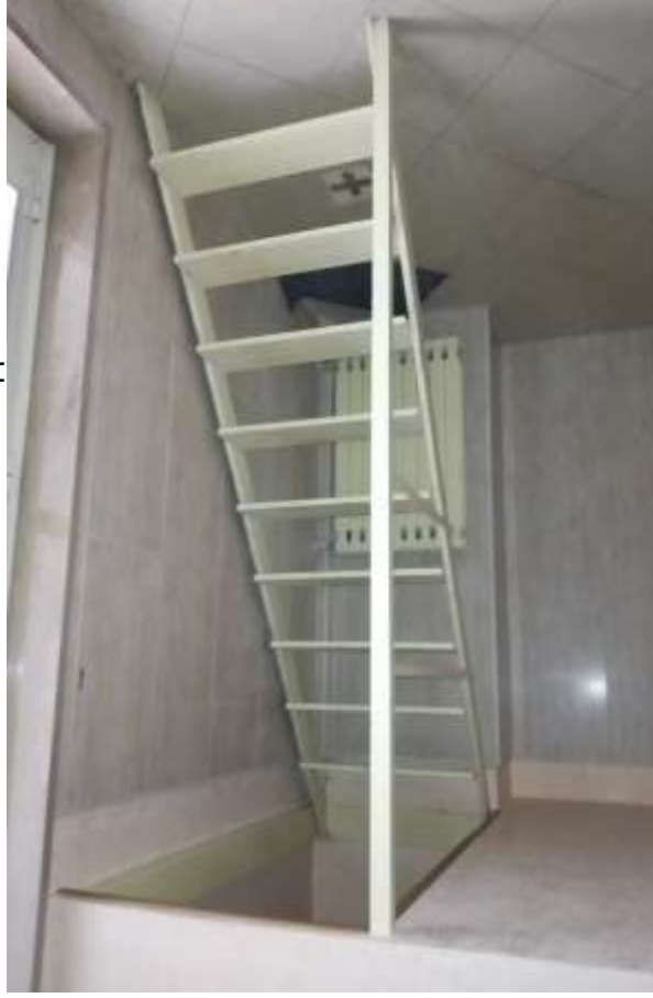
Foto interna ambiente 2- scala di accesso al soppalco
